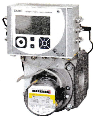
Комплекс модификации СГ-ЭК-Вз-Р с корректором газа потоковым ЕК280
